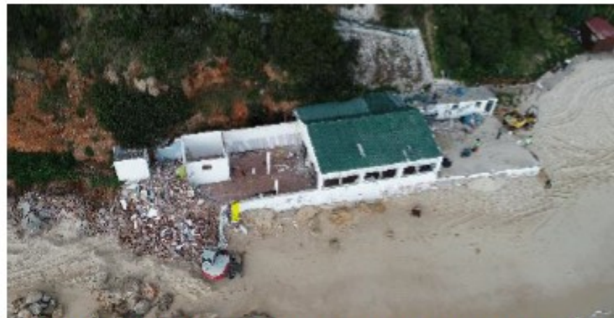
Demolição de construção ilegal na Praia de Galápos, Setúbal, 2021
