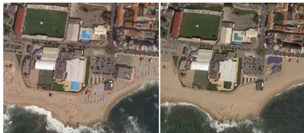
Demolição de apoio de praia na praia Azul, Póvoa de Varzim, 2018
