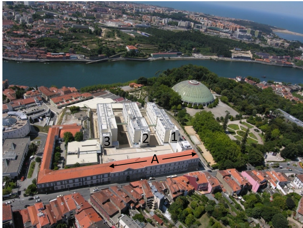
Os 4 novos edifícios do ICBAS/FFUP, rua D. Manuel II, Porto
